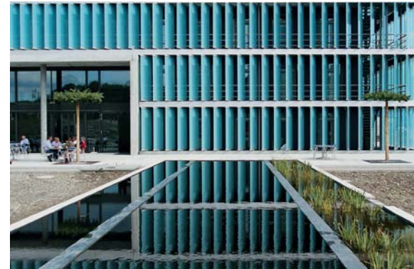
Personalrestaurant und Regenwasserspeicher www.forumchriesbach.eawag.ch
